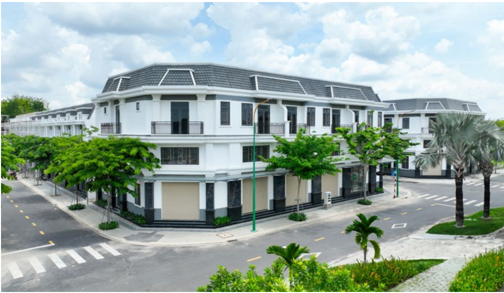
Một dãy nhà phố Richland Residence đã hoàn thiện
