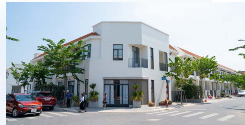
NOXH Richland Residence cũng đã được xây dựng hoàn thiện
