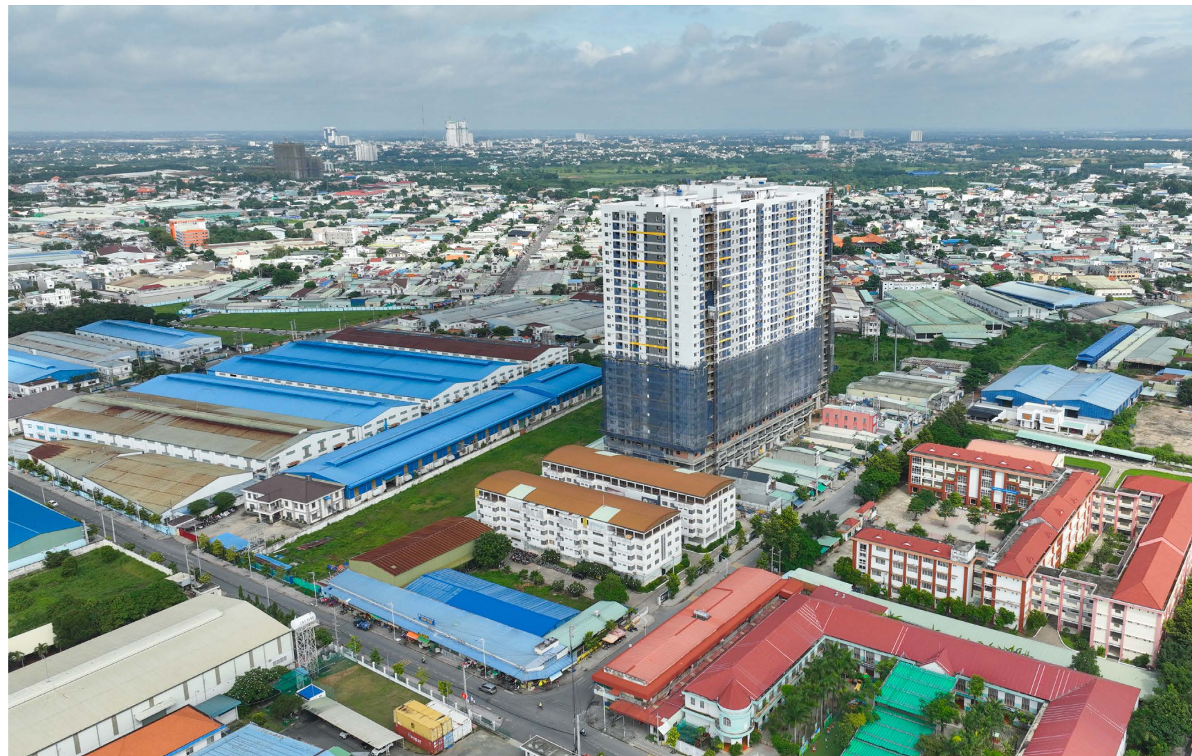
Dự án Legacy Prime đang được hoàn thiện chi tiết, chuẩn bị bàn giao nhà cho khách hàng
