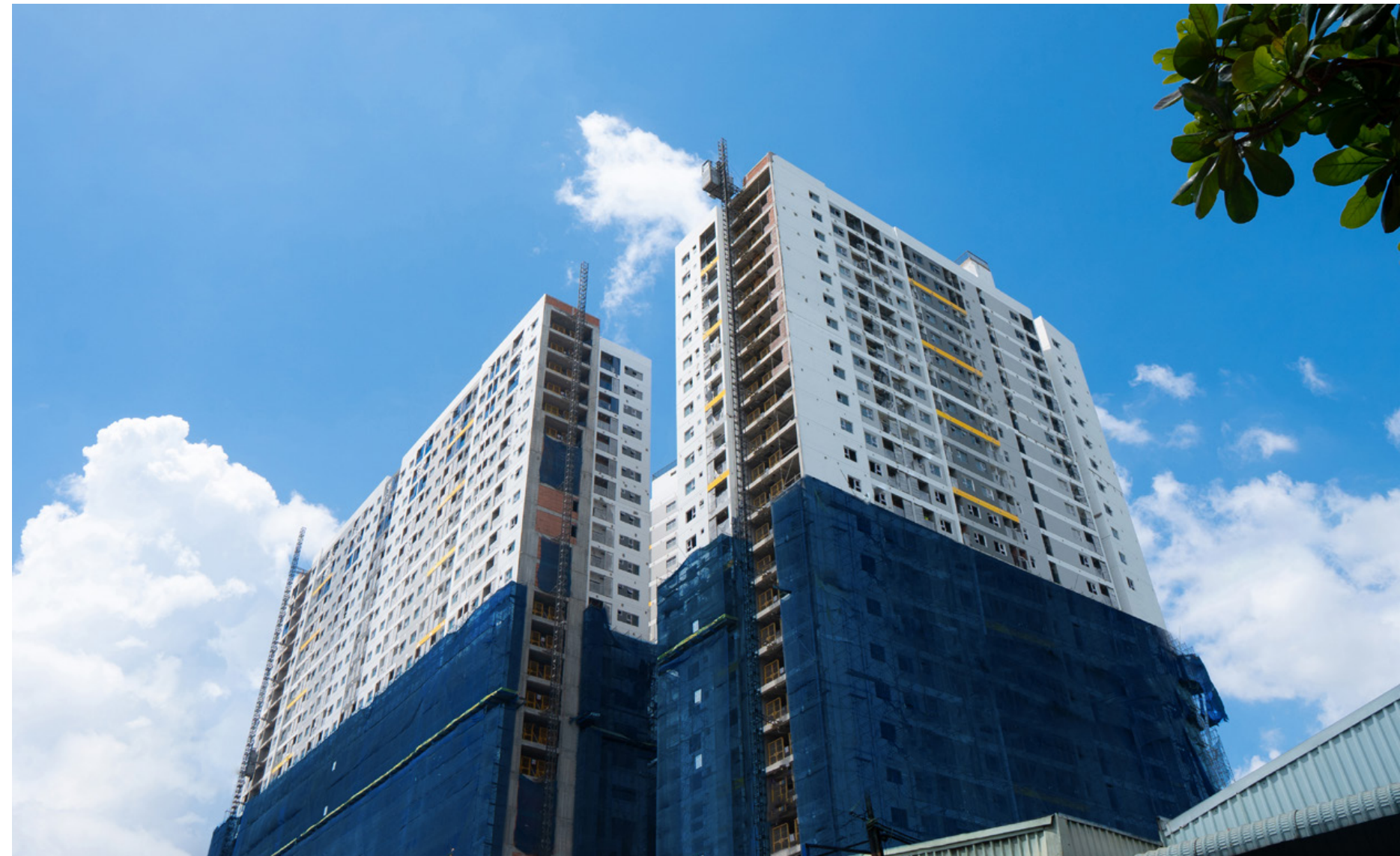
Legacy Prime đang thi công hoàn thiện, dự kiến bàn giao cho khách hàng vào ở trước Tết nguyên đán.
