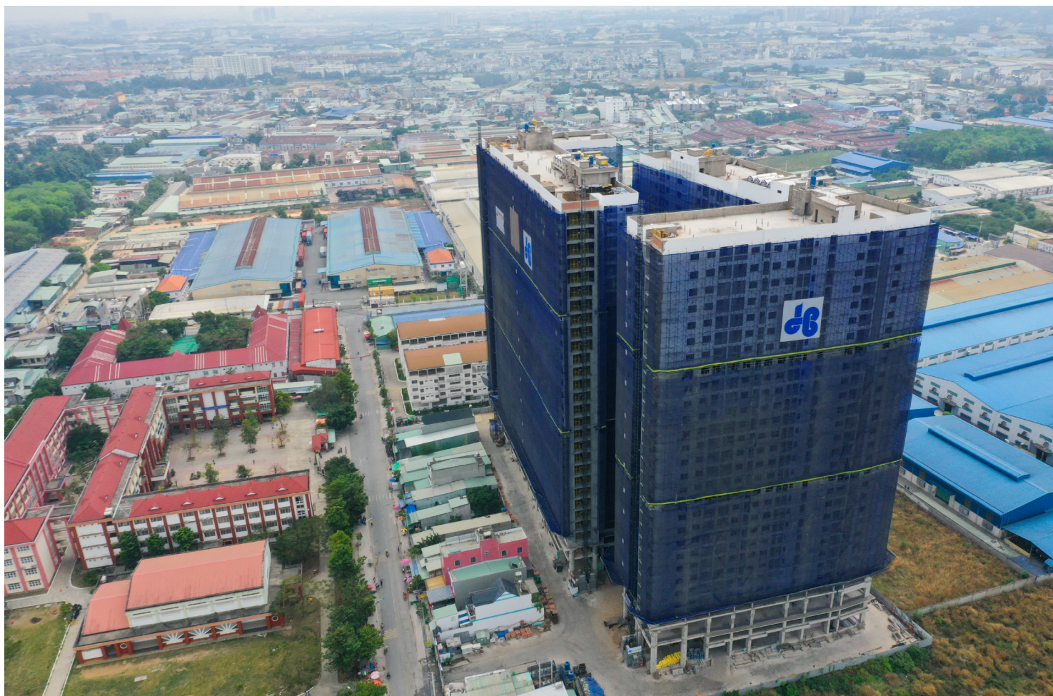
Legacy Prime đang hoàn thiện, dự kiến bàn giao nhà trong năm 2023
