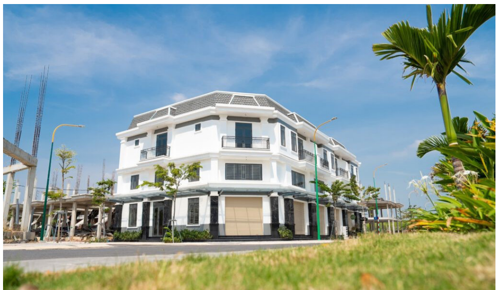
Những căn shophouse nằm trên trục đường chính của dự án đã hoàn thành
